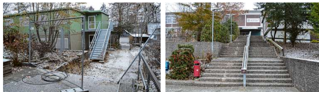
Wentorfs Gymnasium liegt am Hang, das erschwert die Erneuerung der Außenanlagen für die neuen Container auf dem kleinen Parkplatz. Viele Treppenstufen führen zum Haupteingang
