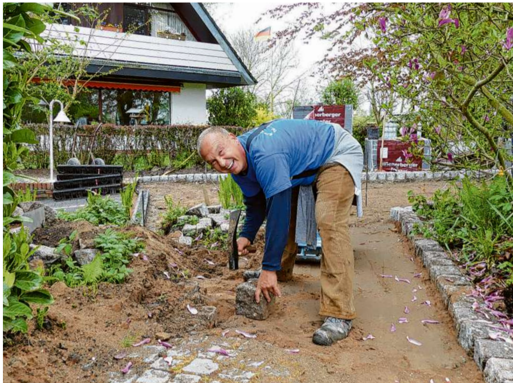
Thorsten Sill verlegt bei einem Kunden Granitsteine für einen Weg.
