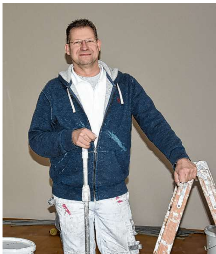
Malermeister Andreas Nilsson bei der Renovierung eines Wohnraums in Havighorst. Foto: Mommert
